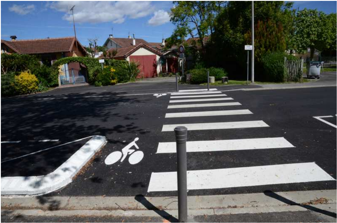
Connexion rue du Lacaoü - coulée verte
