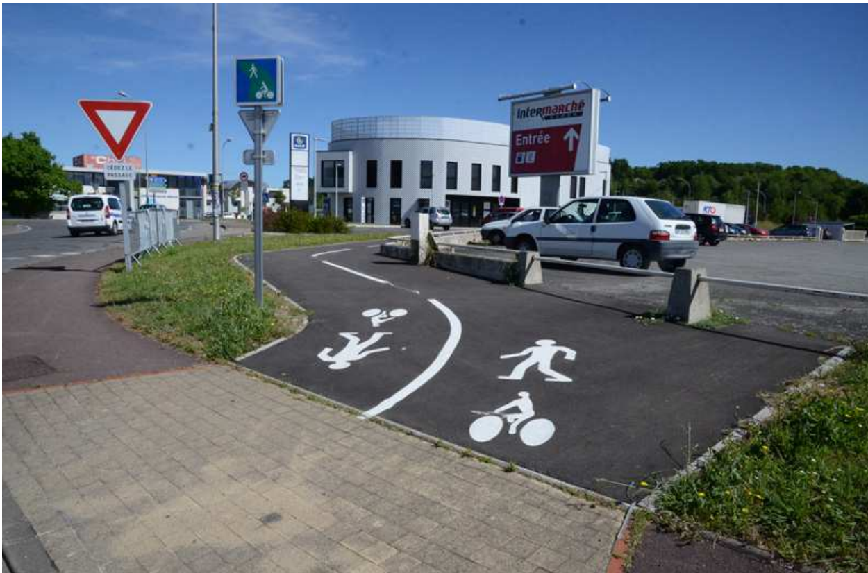
Connexion route de Bayonne - rue du Piémont
