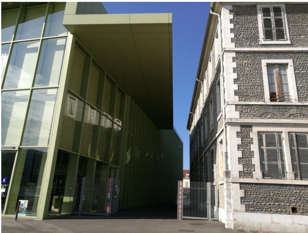
Figure 1 - Auvent Est de la Médiathèque
